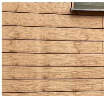
Abb. 2 Wasserstaubflecken
